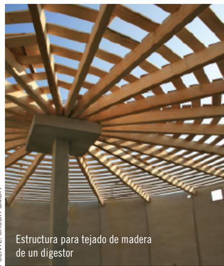
Estructura para tejado de madera de un digestor
