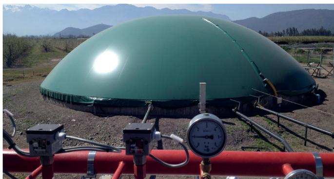
Nota: de 2.000 m<sup>3</sup> de capacidad de tratamiento de purines de 700 vacas estabuladas, producción de 120 m<sup>3</sup> de biogás/hora, a utilizarse en equipos de cogeneración de 200 Kw de potencia instalada (producción de electricidad y calor). Fuente: Matías Errázuriz, Genera Austral, 2017
