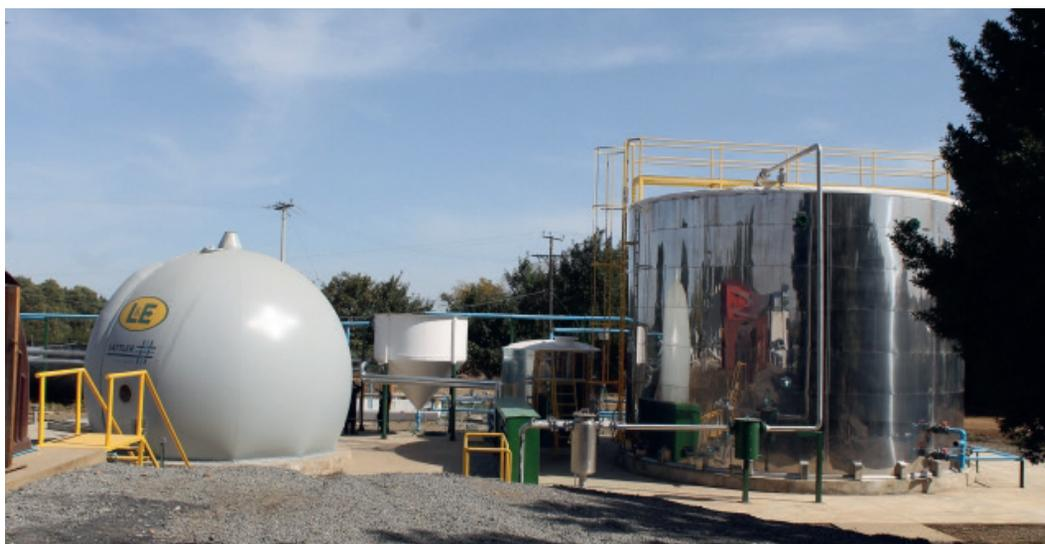
Nota: Tratamiento de 250m<sup>3</sup>/día, potencia instalada de 0,6 MW operativa en caldera de generación de vapor para deshidratación de suero de leche.
