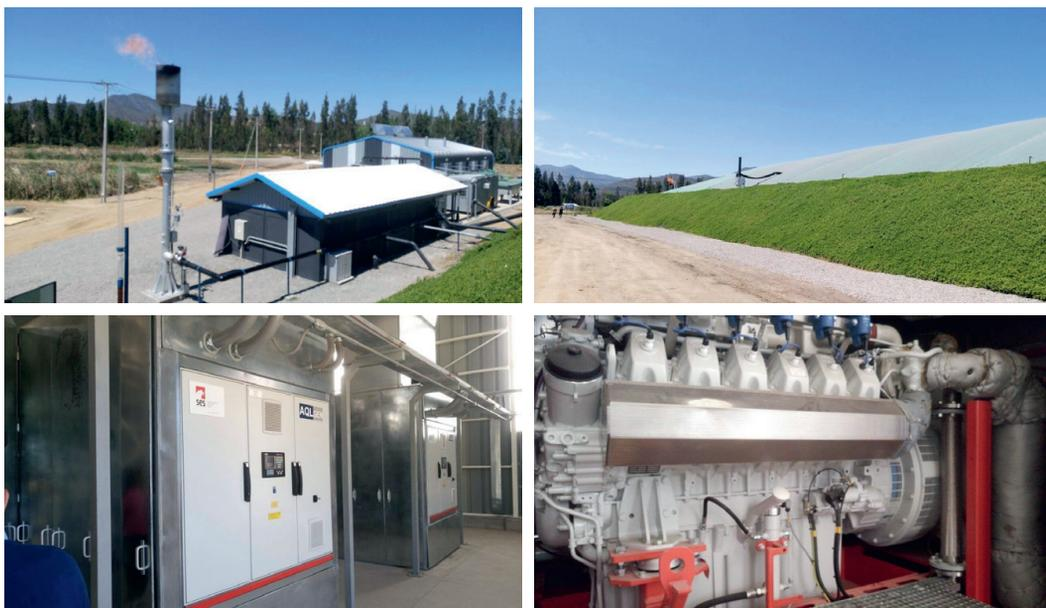
Nota: En sentido del reloj: Biodigestor de laguna cubierta (30.000 m<sup>3</sup>), cogenerador (2 por 520 KW c/u), sala de máquinas, y visión general del sistema de tratamiento y uso del biogás (antorcha de 450m<sup>3</sup>/hora).
